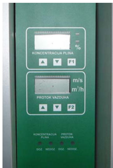
Слика 8. Индикатор протока ваздуха и концентрације штетних гасова у радном простору
